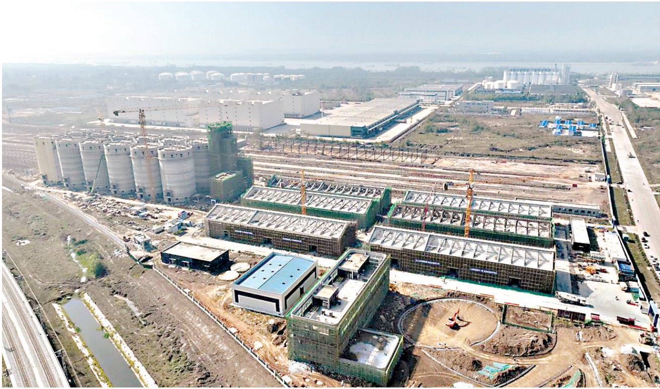
位于新洲区双柳街道的江北粮库项目封顶。
