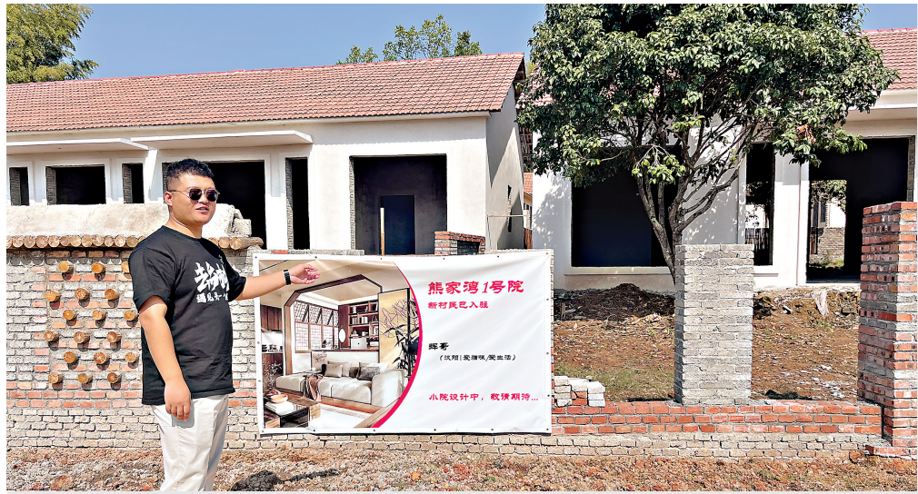
房屋及院落的具体设计和装修,可有意入住的“新村民”自己完成。长江日报记者杨晓雨 摄
