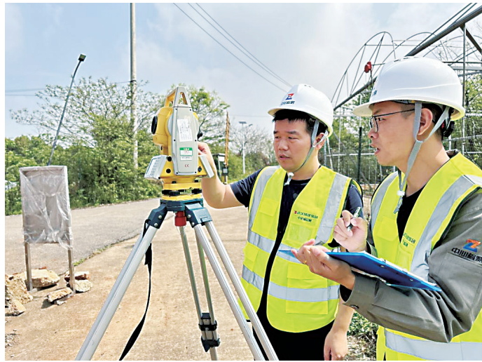
城建集团中心工程检测公司项目攻关小组在对房屋进行安全检测。
