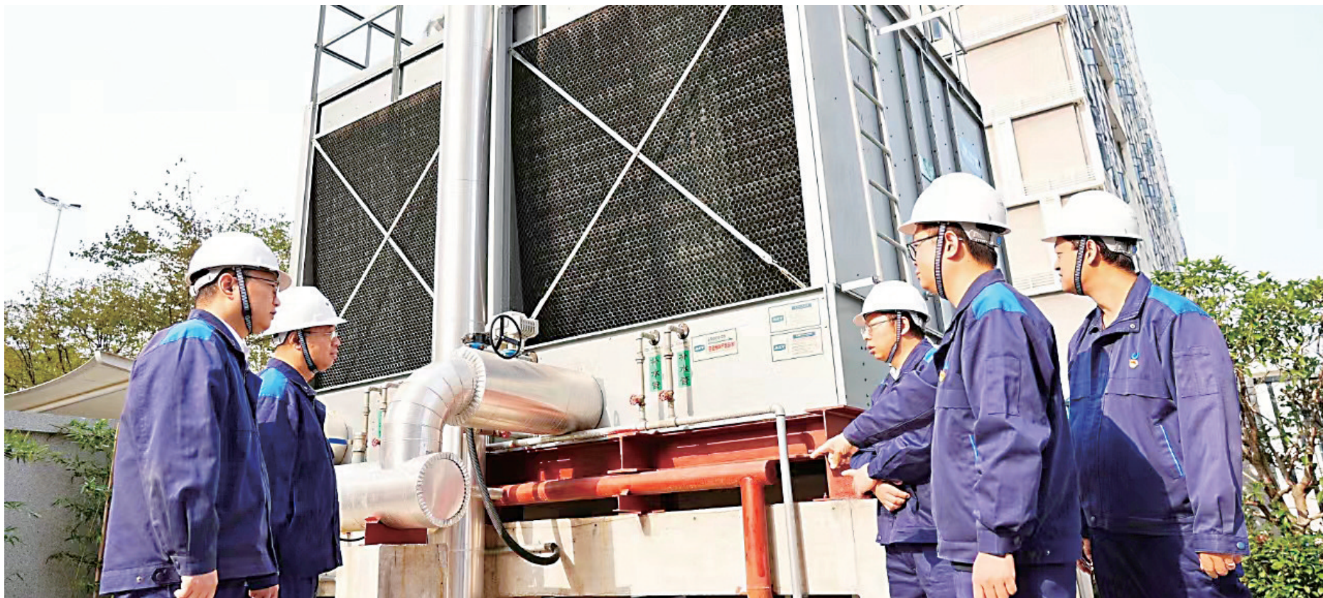
城投集团所属能源设计公司攻关团队在进行冷却塔调试工作。
