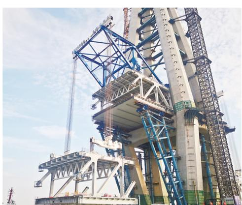
图为全球最大吨位桥面吊机。
