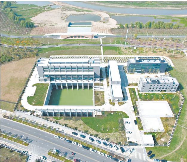
完工的将军路泵站。
