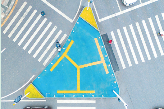
新建的彩色混凝土交通岛,既实现道路零高差,还美观耐用。
