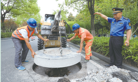
城管人员指导施工人员更换“问题井盖”。
