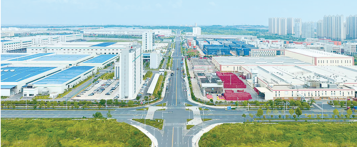
长江新区智能制造产业园园区实景。
