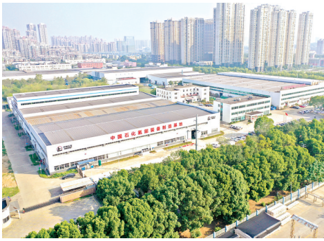
中国石化氢能装备制造基地。
