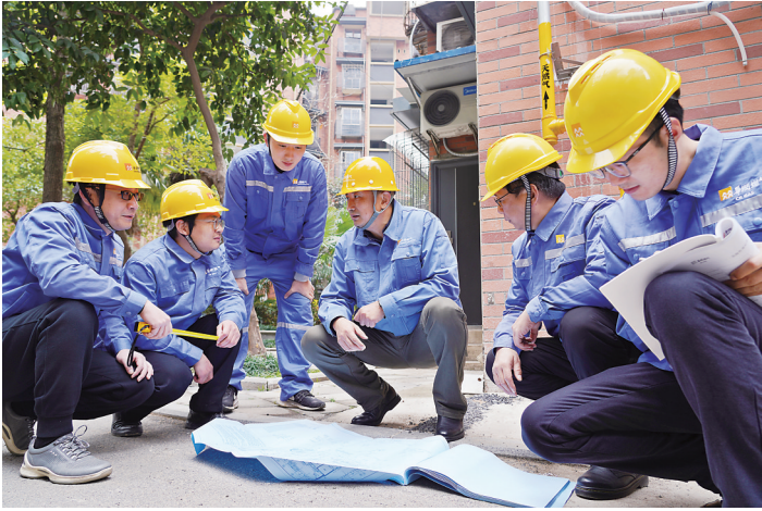
华润燃气武汉区域公司发动党员先锋队力量,整体突进开展问题管网排查。
