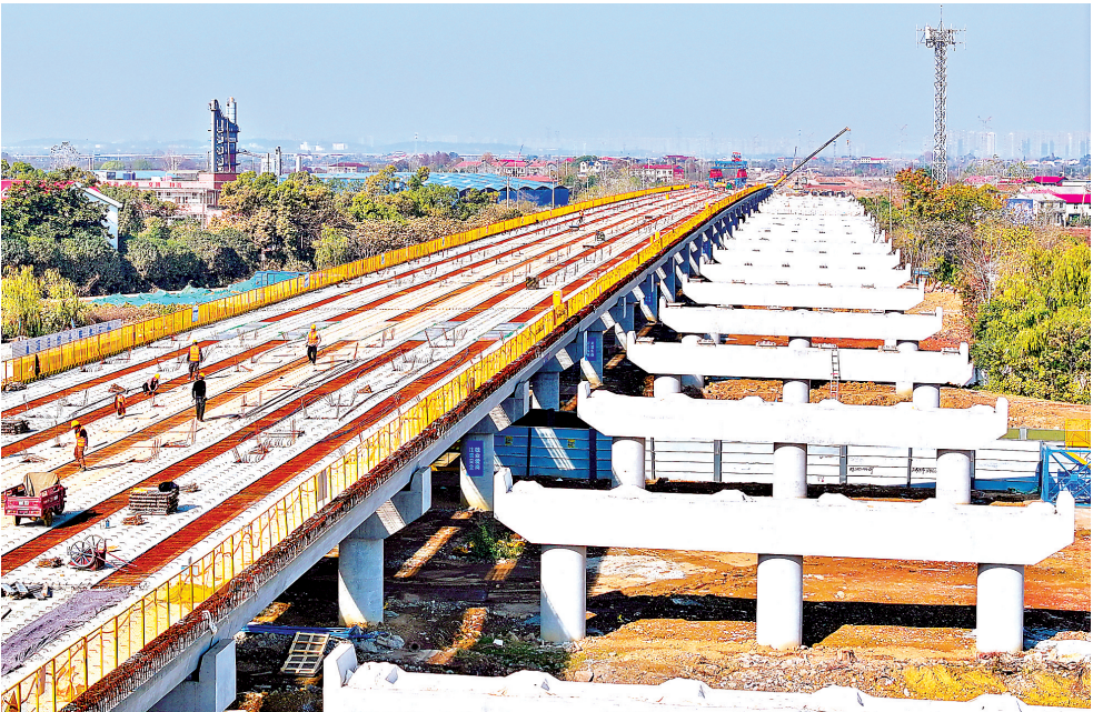
12月6日,沪渝高速武黄段(武黄高速)改扩建项目蒲团大桥左幅架梁工作完成。目前,沪渝高速武黄段和黄黄段正在改扩建,项目完成后,将促进长江中游城市群联动发展。 通讯员王可 摄
