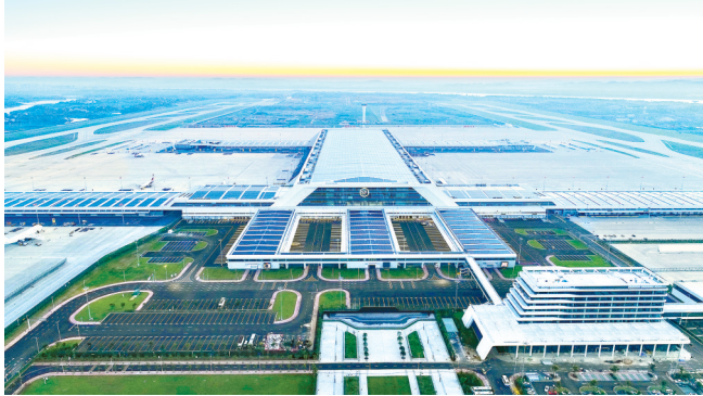
鄂州花湖国际机场顺丰转运中心。
