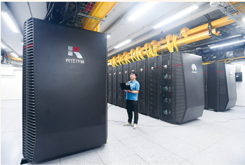
武汉人工智能计算中心，工程人员正在调试设备。
