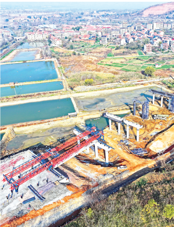
12月18日,塘湾村1号桥开始箱梁架设。
