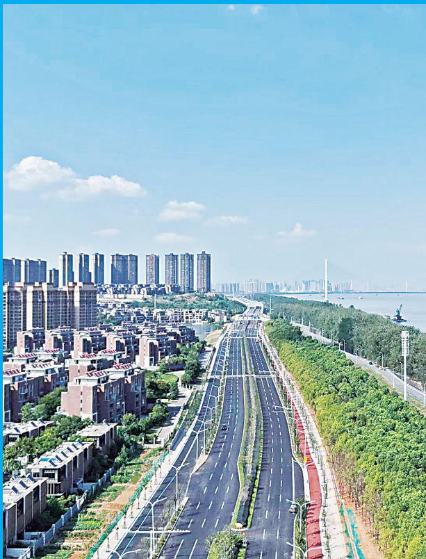
长江主桥左岸大道不断刷新“进度条”。
