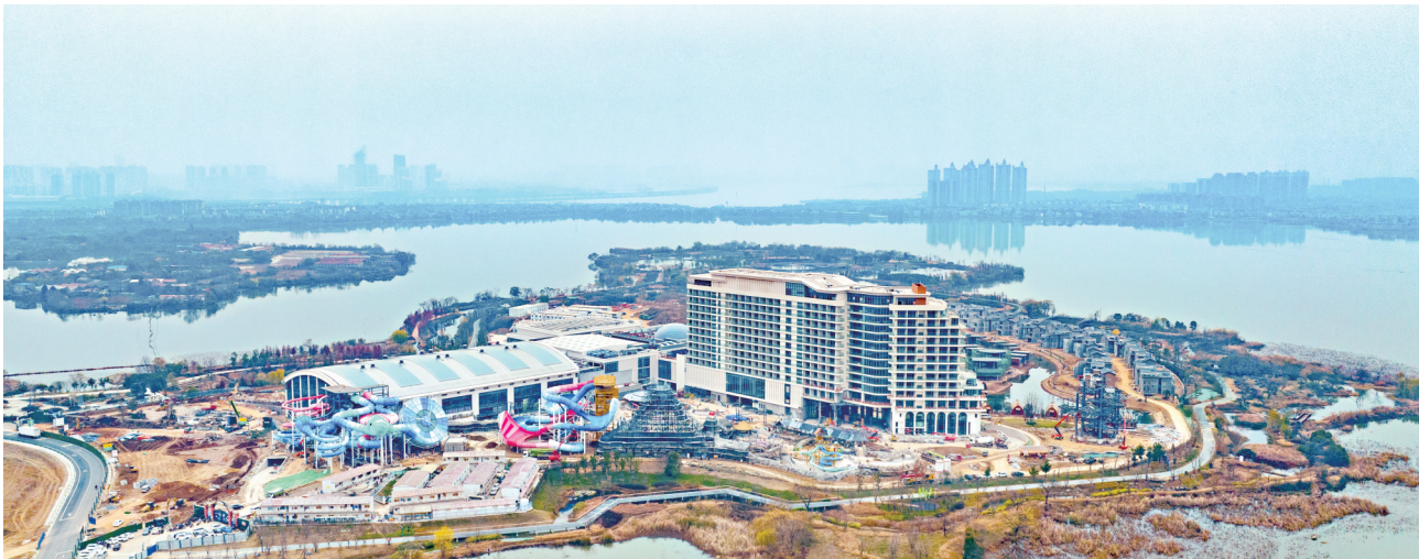
半岛水世界已完成主体建筑施工，明年5月正式对外营业。
