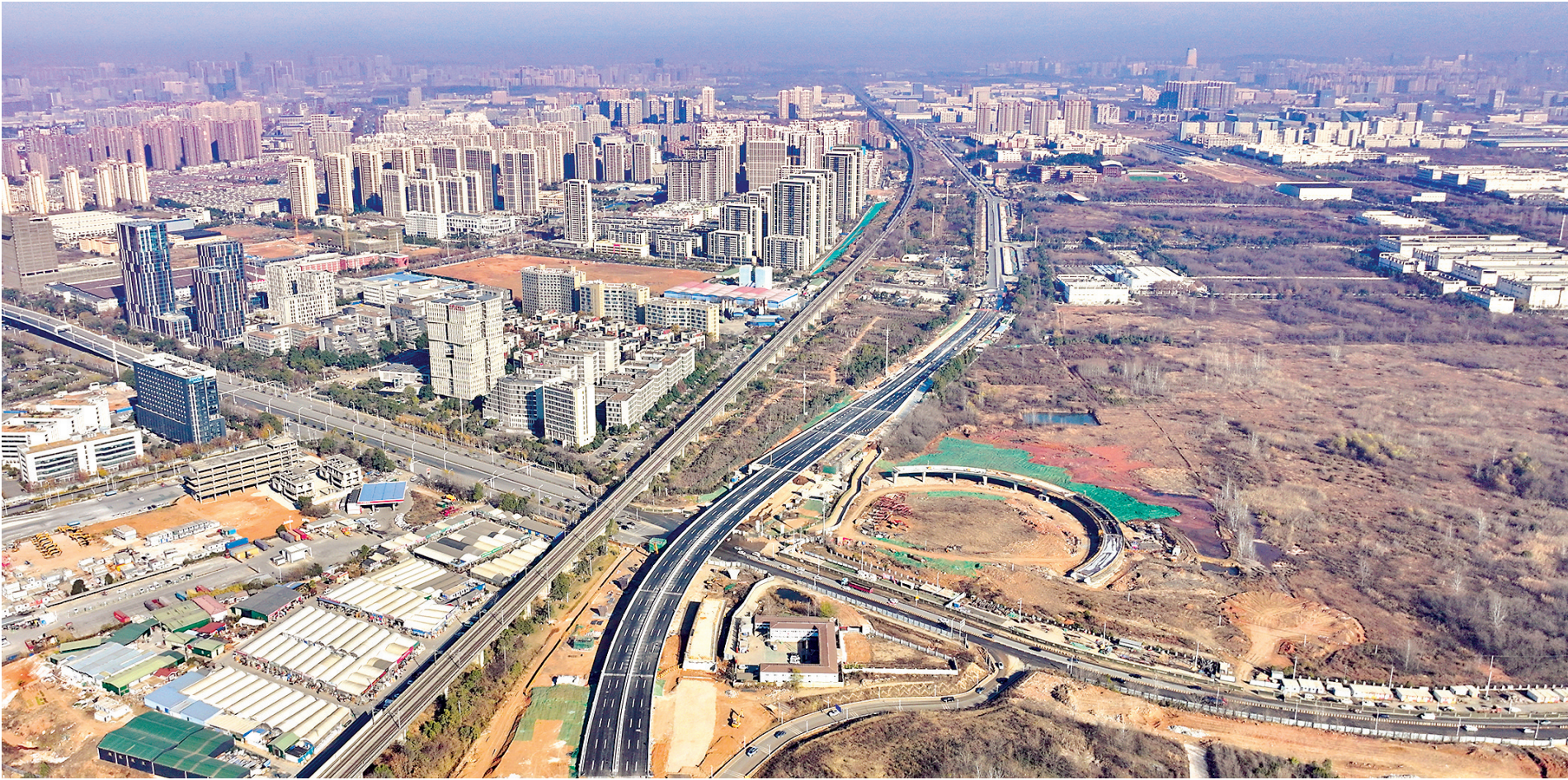
光谷二路跨光谷大道主线桥梁贯通。
