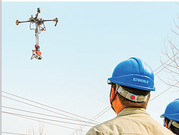
无人机将涂覆机器人拎起,快速进入作业点位。
