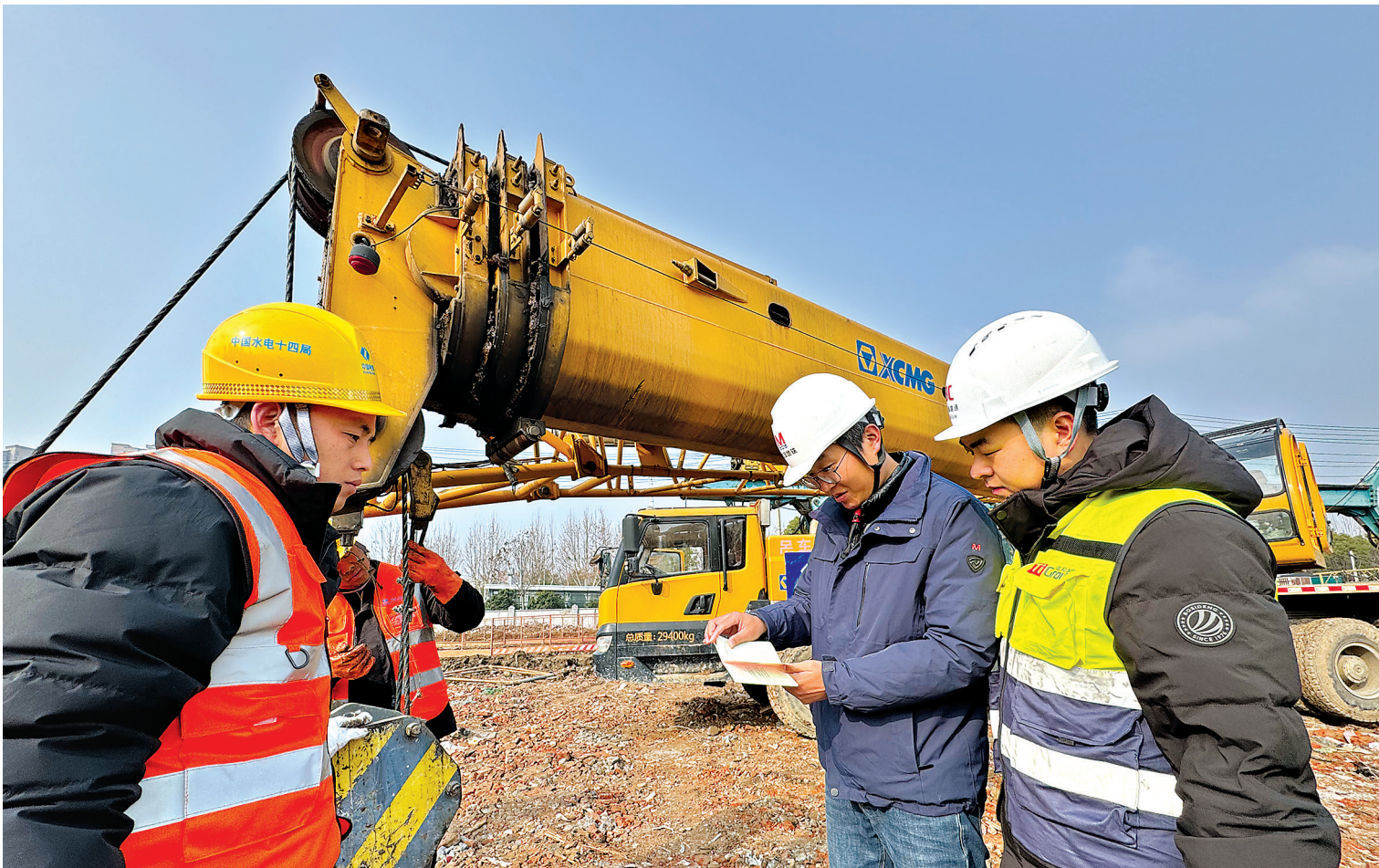
2月4日,地铁业主代表祝雄威(右二)到项目现场检查。
