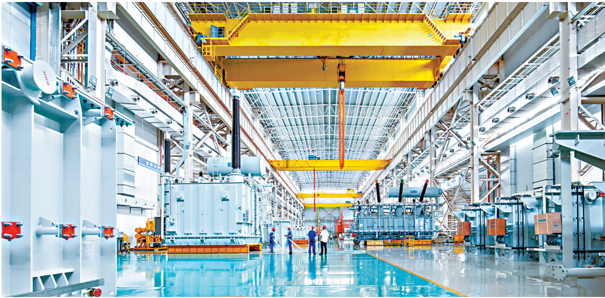
正泰高压电气设备(武汉)有限公司内,工人们紧张而有序作业。
