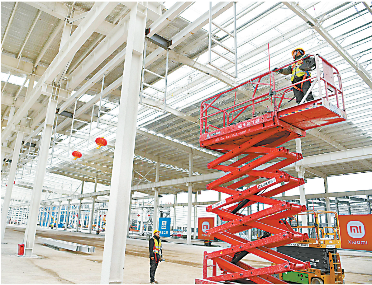
2月5日,小米智能家电工厂项目现场,工人们正在施工。
