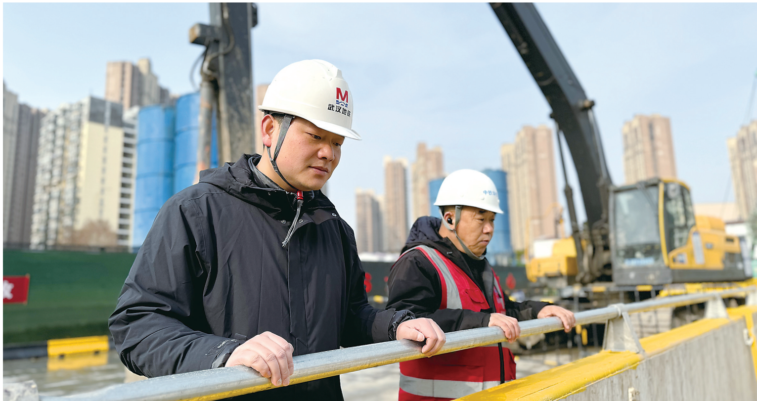
地铁业主代表邱子锋(左)与施工人员正在查看基坑。
