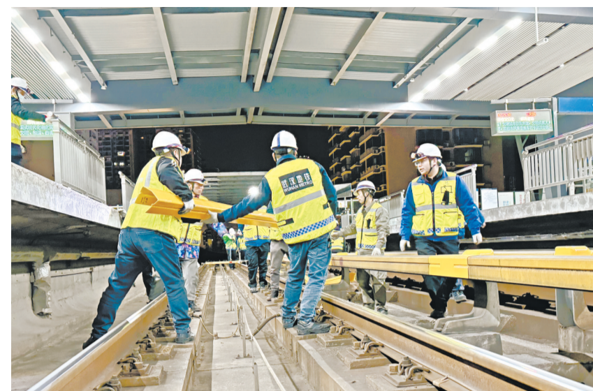
地铁供电专业人员把新防护罩从站台运入正线区间。长江日报记者陶常宁 摄
