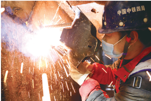
施工人员焊接12号线罗凌区间洞门钢板。通讯员袁永华 摄
