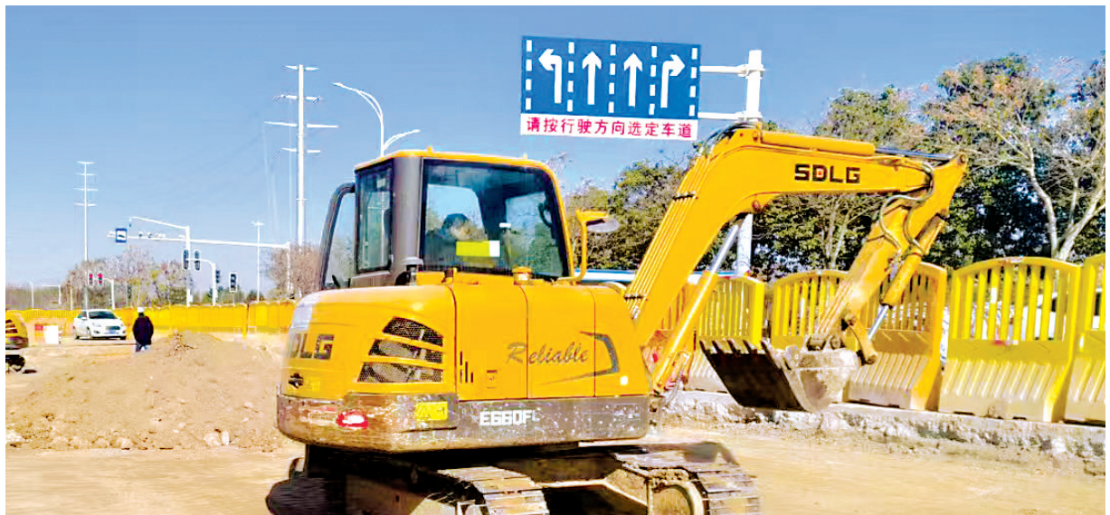
左岸大道汉南段江大路段正在加紧施工中。
