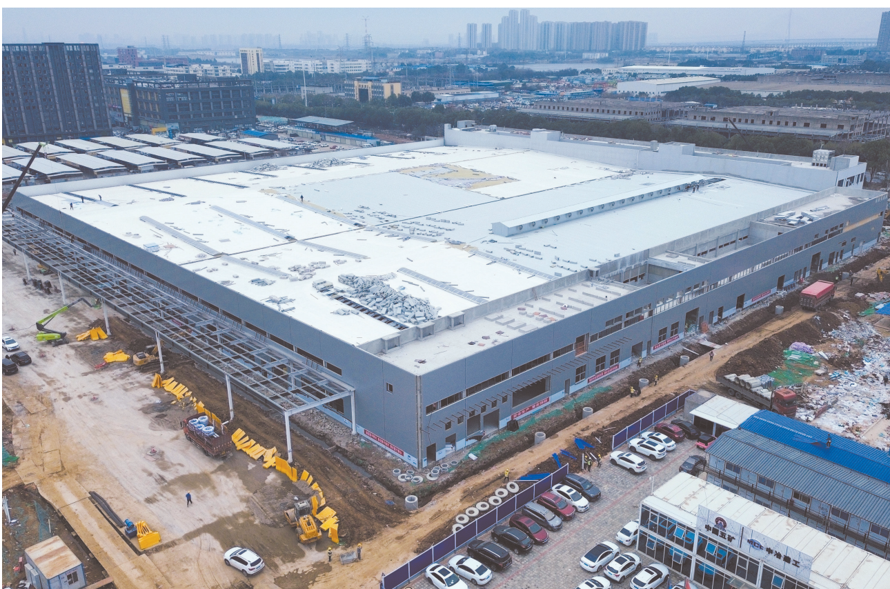
采埃孚汽车制动产品升级项目已顺利封顶。
