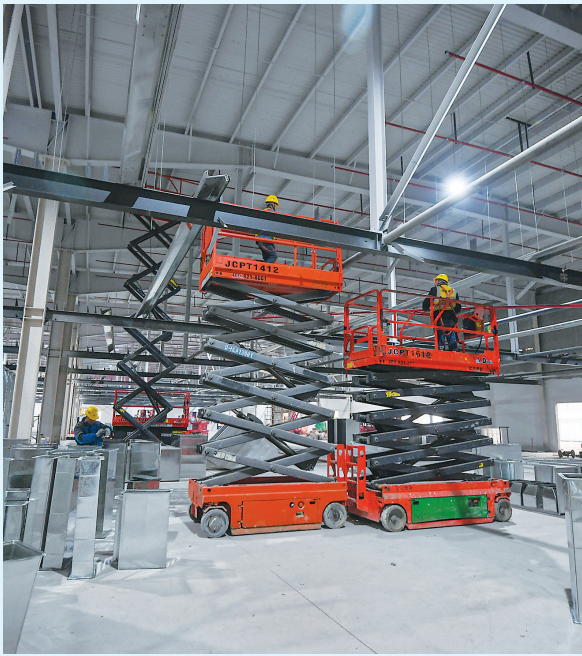
2月11日,采埃孚汽车制动产品线升级项目厂房内,工人们正在进行安装。
