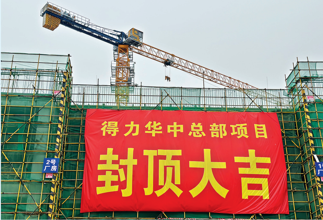
得力集团华中总部项目全面封顶。
