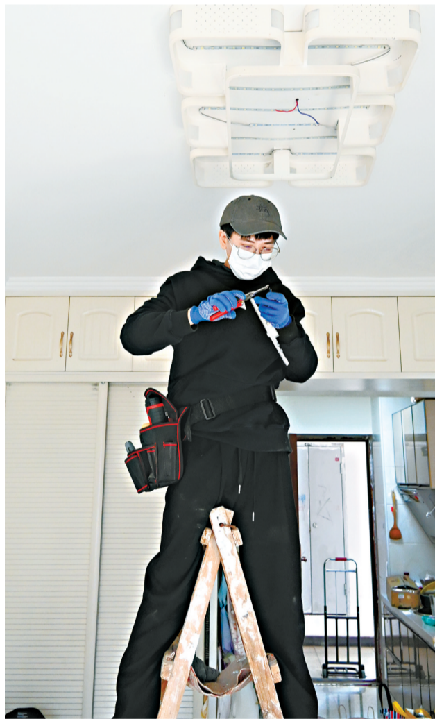
陈哲涵上门为独居女性顾客更换顶灯。
