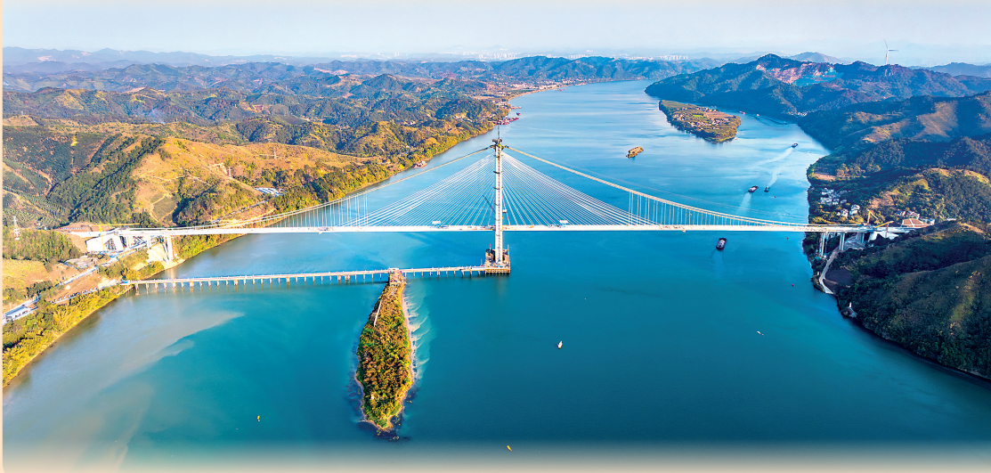
广西藤州浔江大桥
