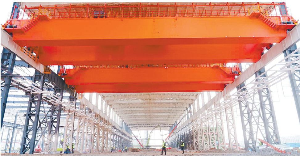
东风汽车一体化压铸产业化项目施工现场。
