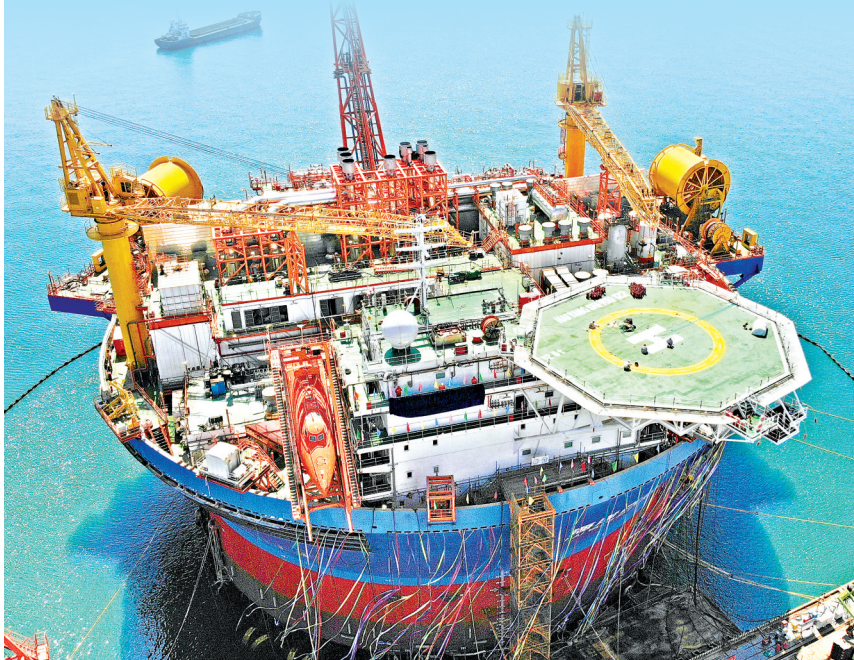
2024年4月26日，靠泊在青岛海洋工程高新装备制造基地舾装码头的“海葵一号”(无人机照片)。
