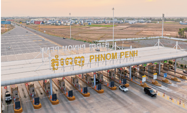
这是2025年3月17日在柬埔寨金边拍摄的金港高速公路收费站(无人机照片)。
