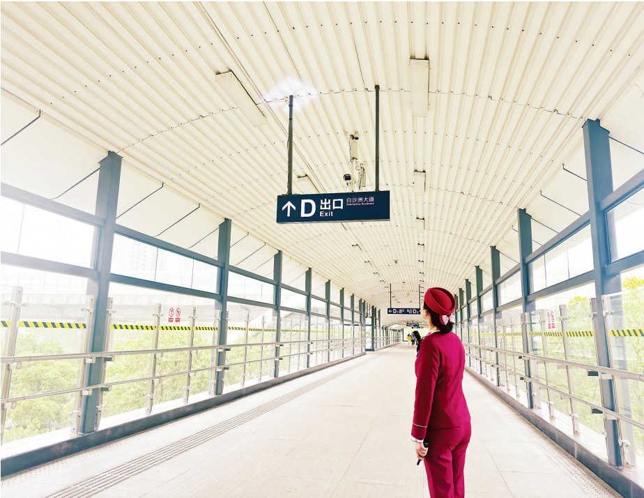
5号线光霞站值班站长检查天桥悬挂标识部件紧固情况。
