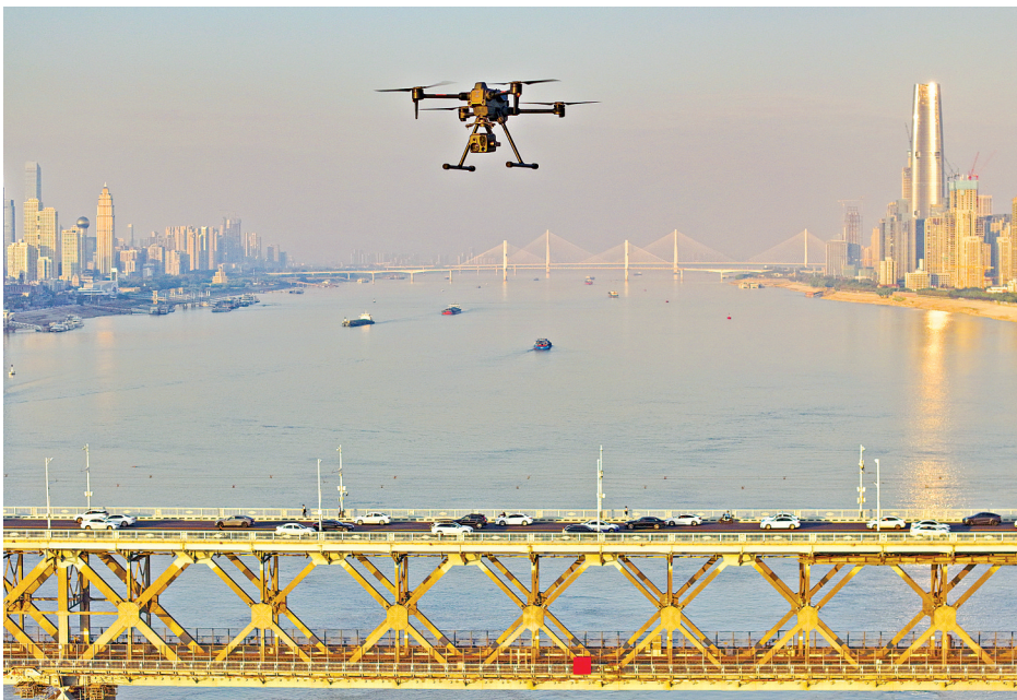
普宙科技无人机S400在武汉长江大桥上空往上、下游方向进行测绘、巡检。S400可通过一系列自动化技术实现全自主飞行,代替人员控飞和外出作业。 长江日报记者胡冬冬 摄
