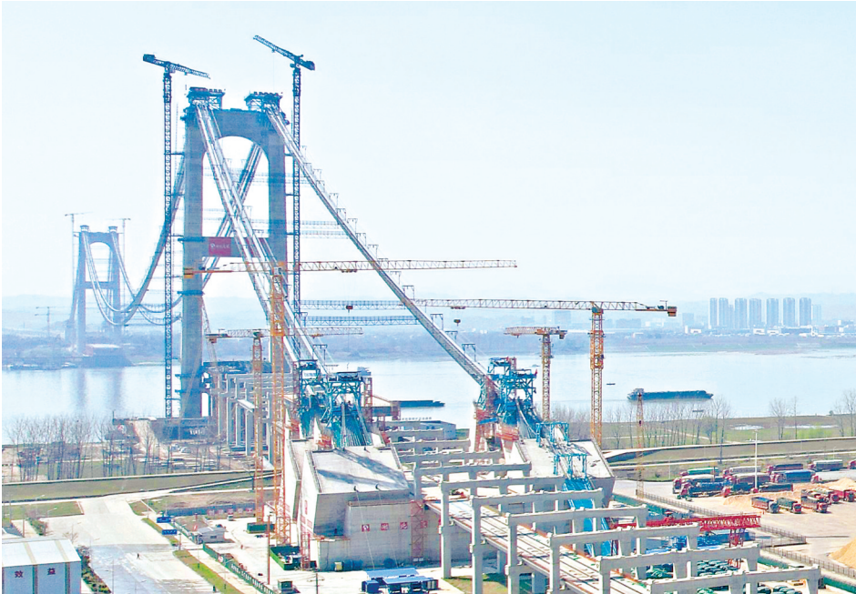
燕矶长江大桥正在进行主缆架设。
