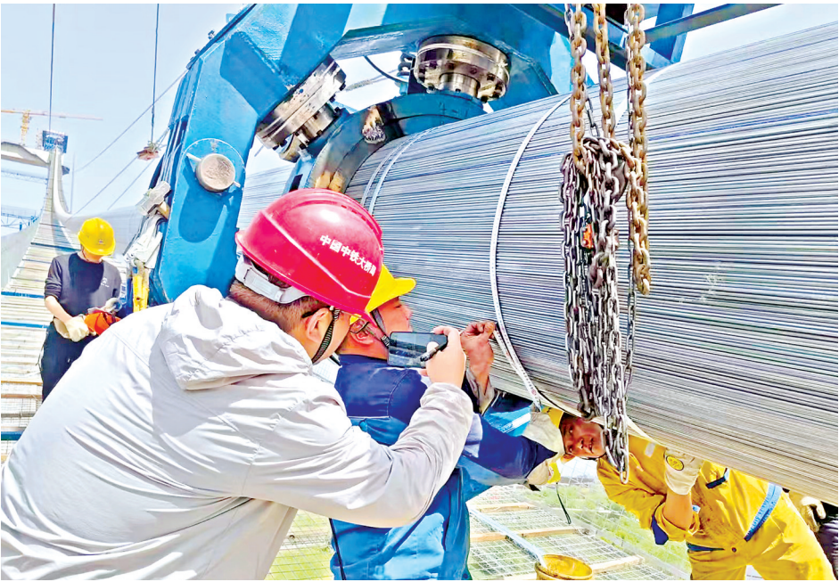
双柳长江大桥项目现场,工人们正在进行主缆紧缆施工。
