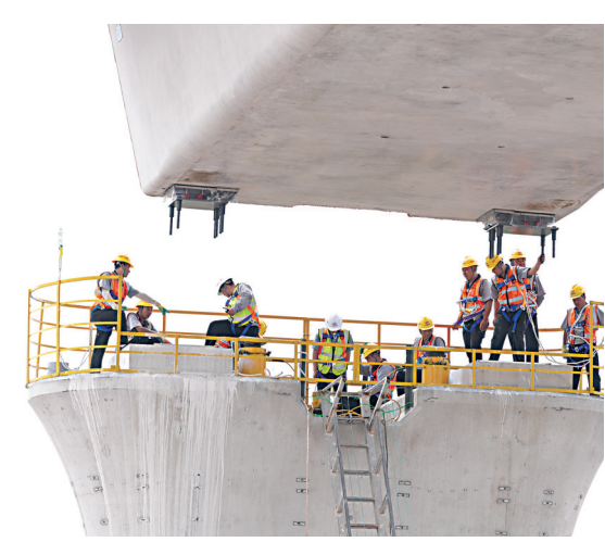
合武高铁箱梁架设过程中,误差控制在2毫米以内。
