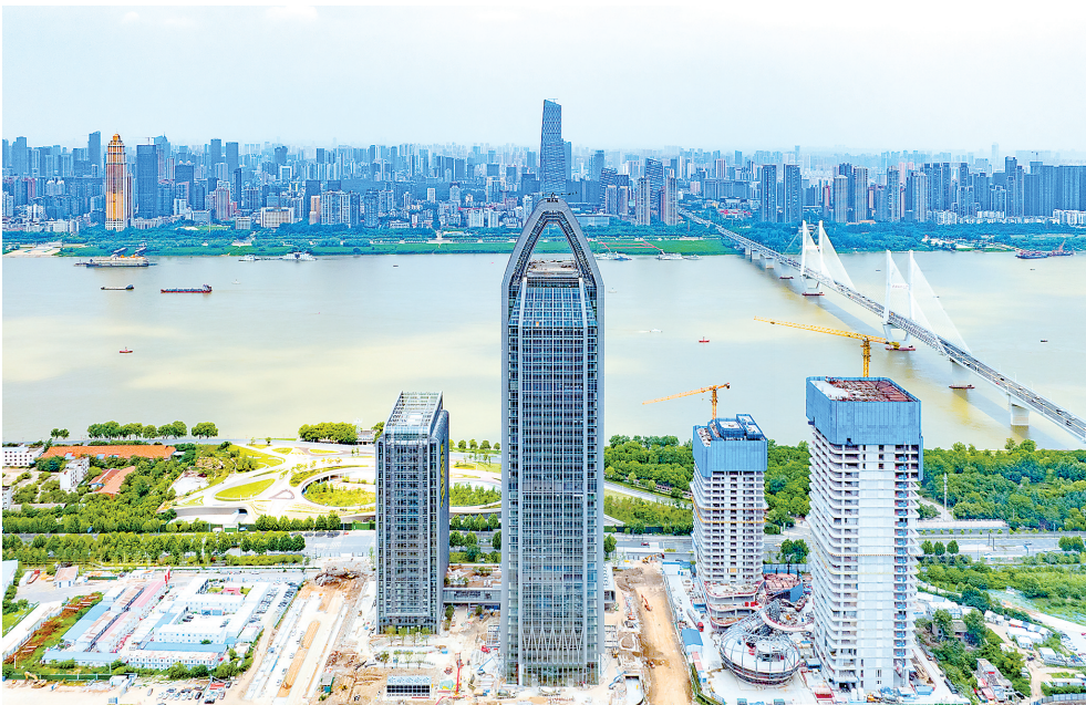
正在建设中的国铁城投中心,造型如同一列竖起来的“复兴号”。
