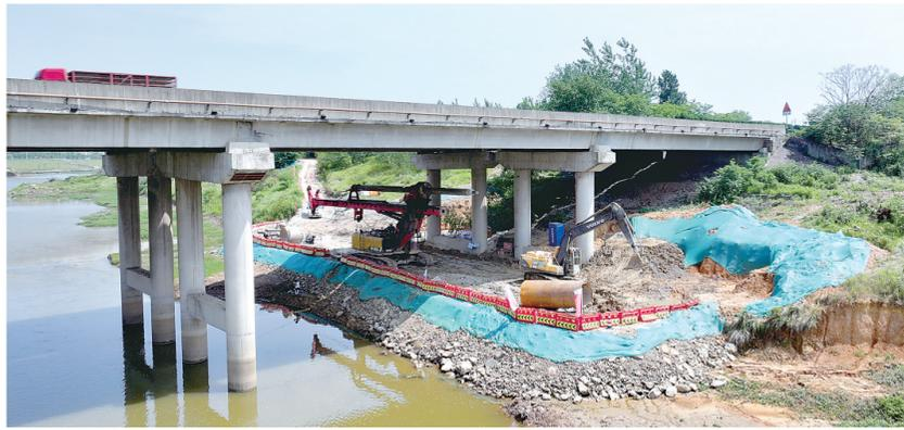
黄黄高速黄梅河大桥,桥下正在进行新桥的桩基作业。
