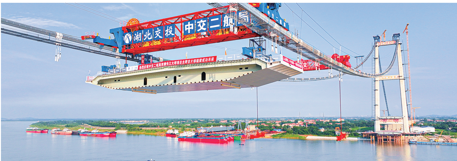
武汉双柳长江大桥正在进行主跨首片钢箱梁吊装。
