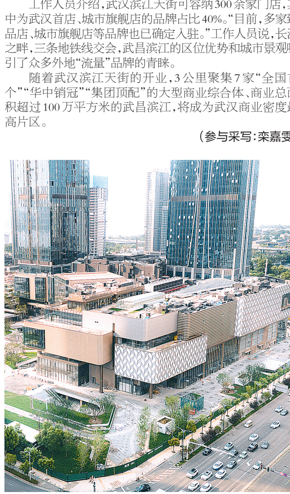
正在加紧建设中的武汉滨江天街。
