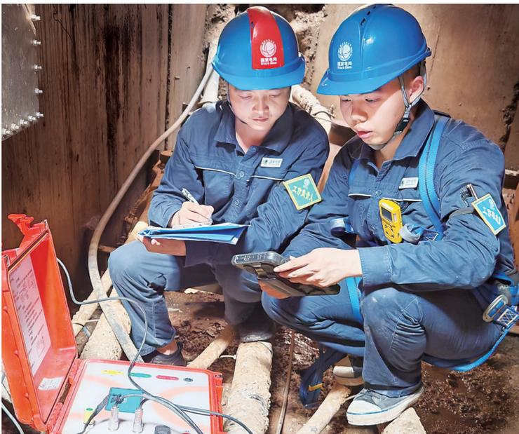
李欣然(左)和刘子孺在井底对电缆接头进行带电检测。 长江日报记者刘克取 摄
