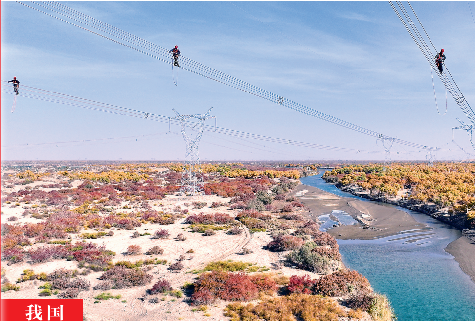
在巴州-铁干里克-若羌750千伏输变电工程现场,作业人员开展作业。新华社发
