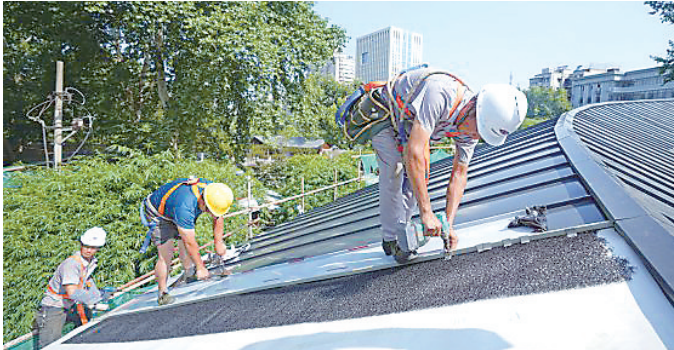
王志波班组在绿色驿站屋顶施工。 长江日报记者明晓生 摄
