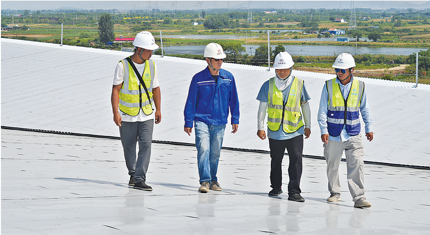
罗文佳(左二)在楼顶与安装工人交流。
