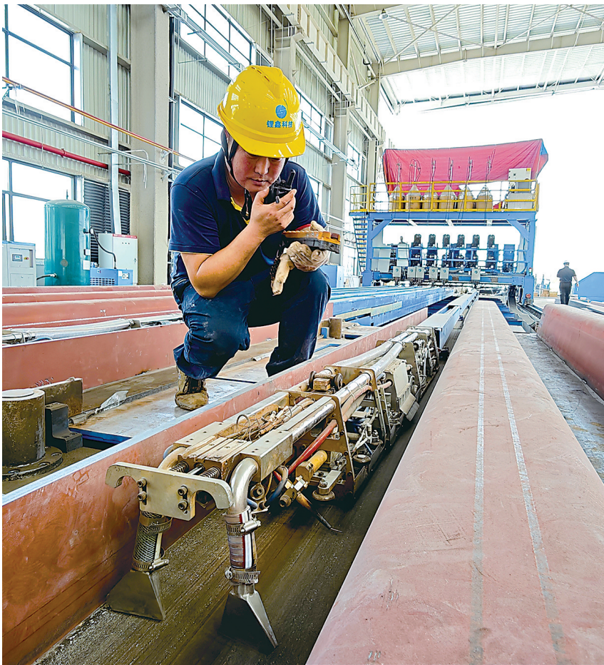
锂鑫科技生产车间内，工程师调试U肋内焊机机器人。长江日报记者何晓刚 摄
