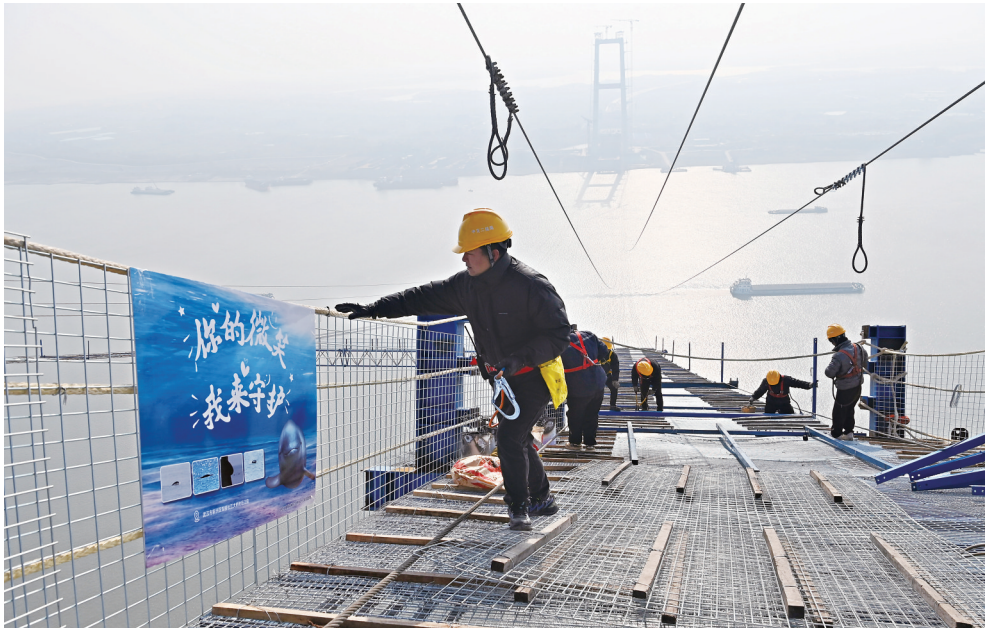
2024年12月13日,双柳长江大桥猫道铺设现场,一块“你的微笑我来守护”长江江豚保护宣传牌旁,建设者正在施工。
