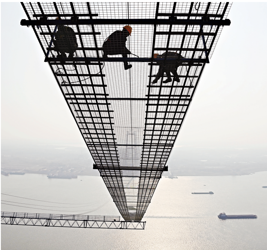
2024年12月13日,施工人员在双柳长江大桥铺设猫道。为防止施工材料掉进长江,施工人员在猫道上铺设了密实的钢网。
