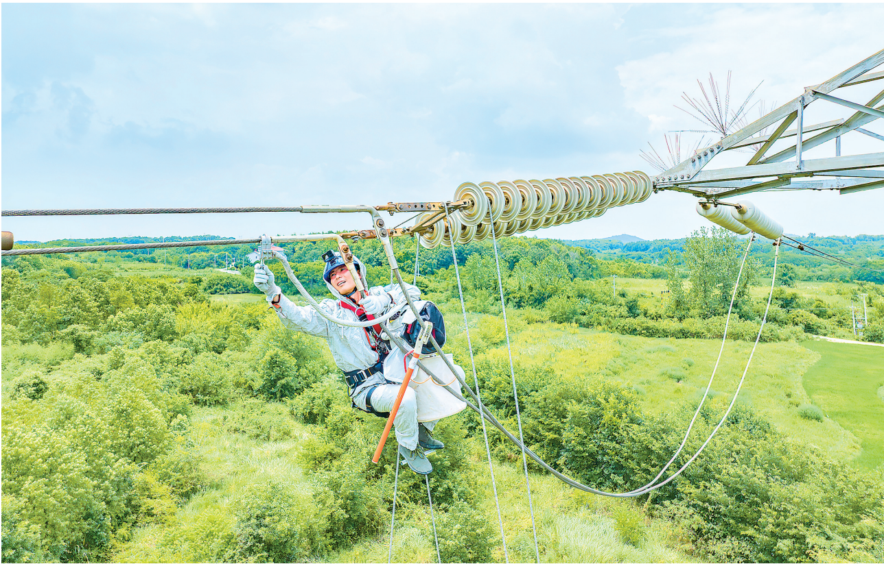
供电运检人员在36米高空带电作业。 通讯员张恒 摄
