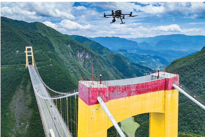
桥梁无人机智能检测系统正在检测主塔。
