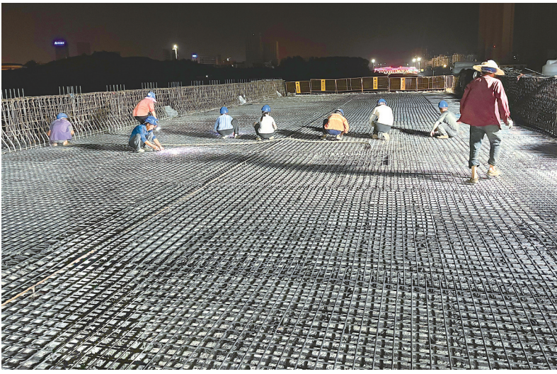
7月31日晚，高新三路项目现场，工人们正在挑灯夜战。
