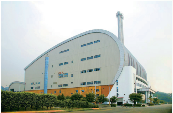
广州李坑生活垃圾发电项目。
