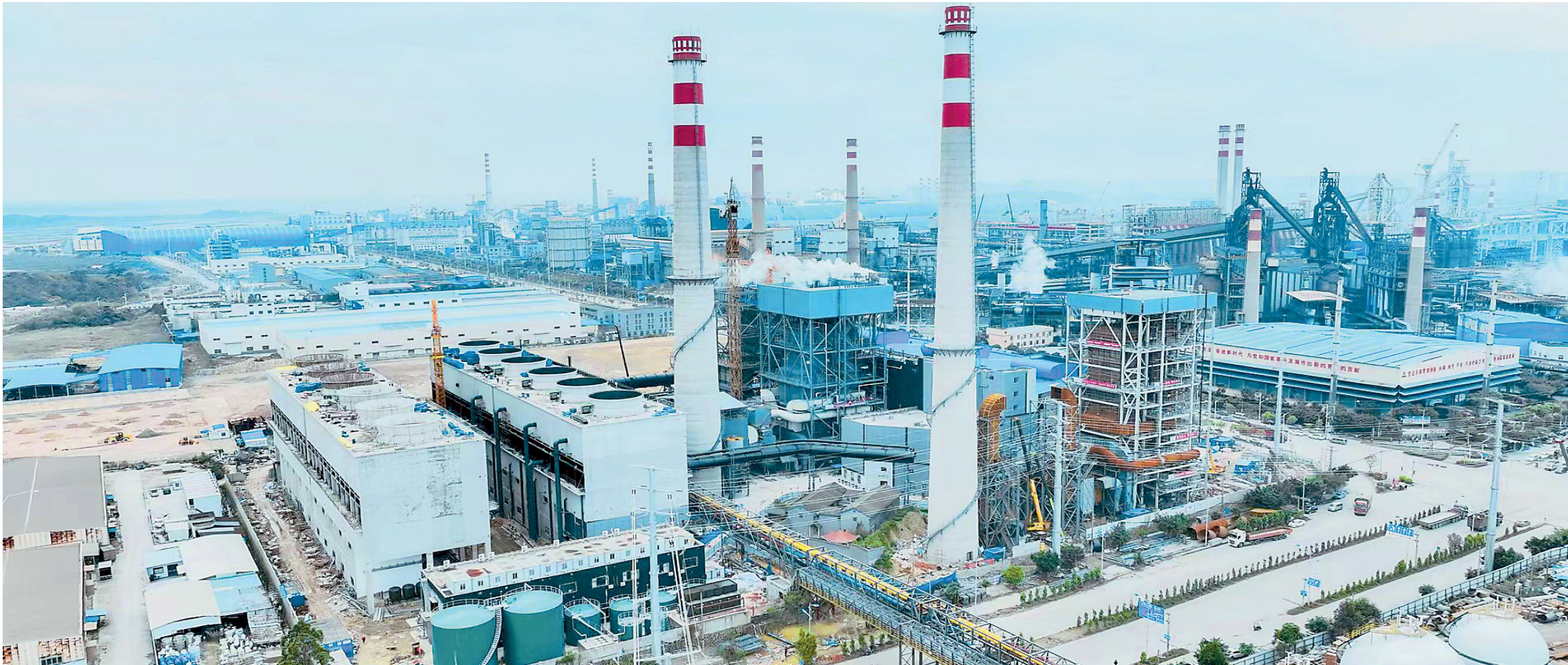
广西盛隆冶金超临界煤气发电项目。
