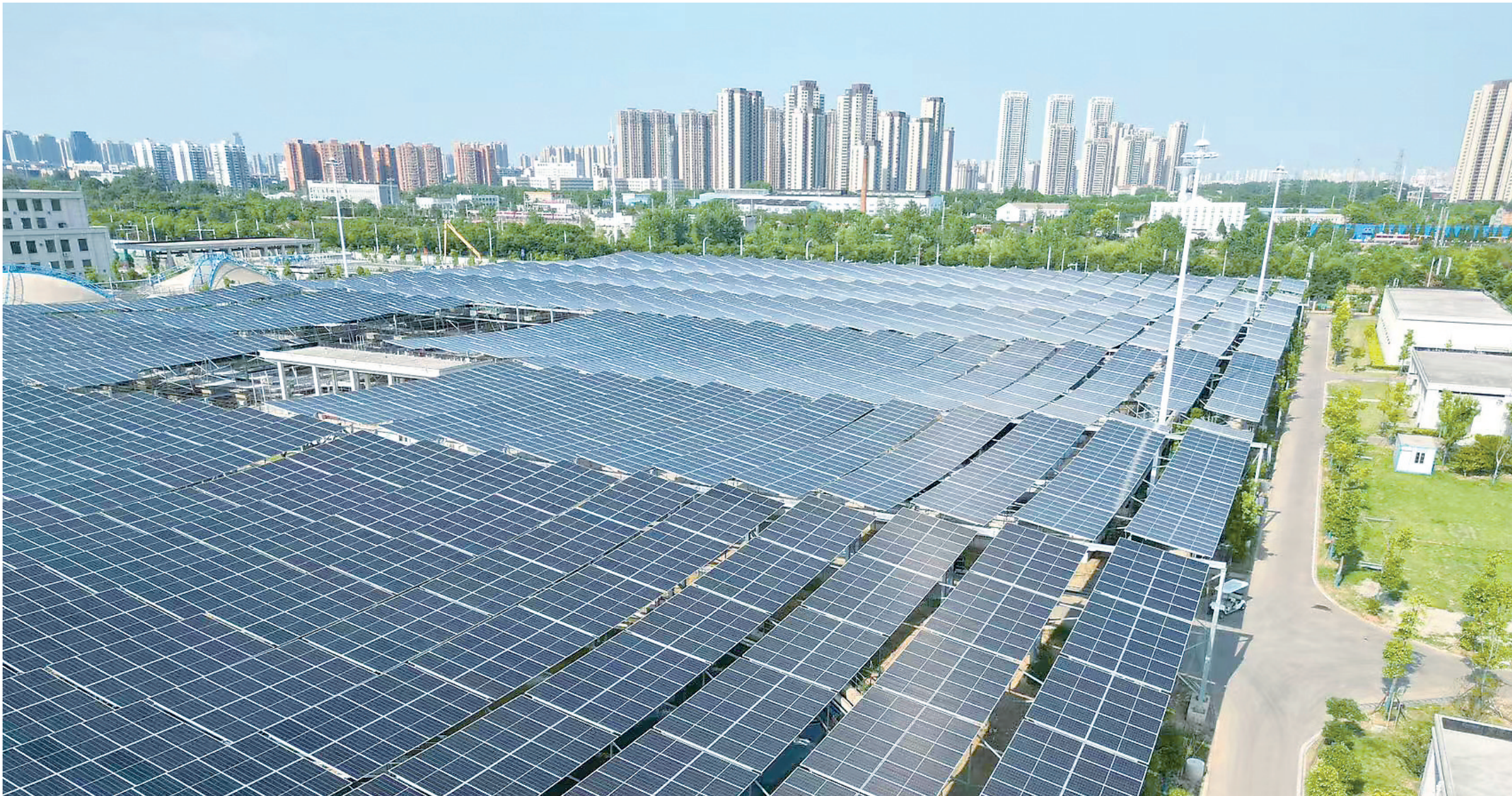
黄家湖污水处理厂三期光伏项目,通过“自发自用、余电上网”模式实现绿色清洁能源的高效利用。
