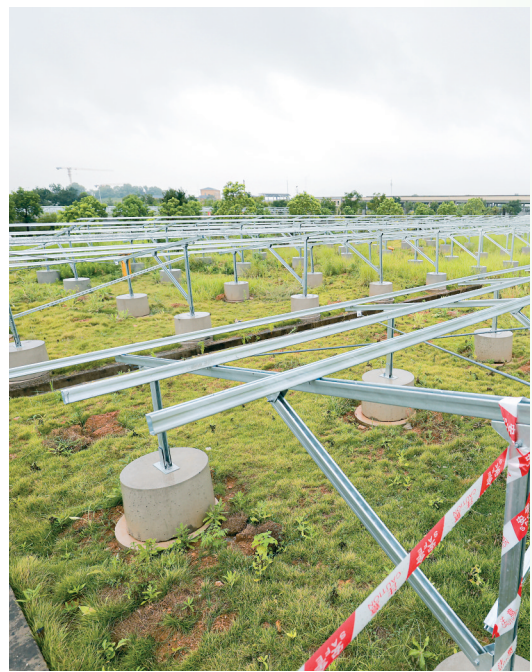
金口水厂正在建设的光伏项目。
