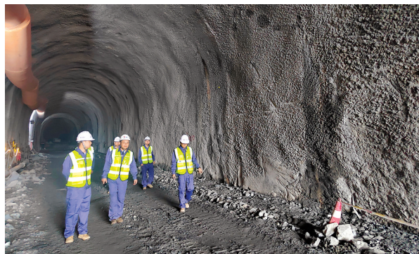
湖北大冶深地储氢科研中试基地项目建设现场。
