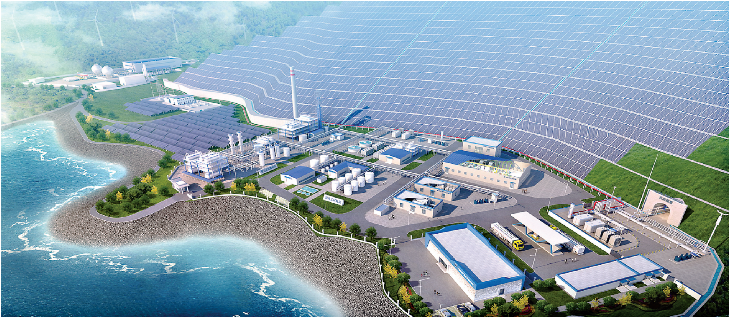
湖北大冶深地储氢科研中试基地项目。
